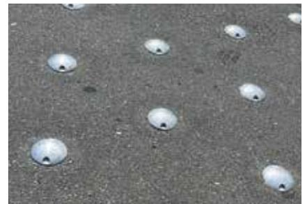
**Recomendación de Mantenimiento:** Se recomienda lavar periódicamente las piezas con sistema de agua a presión con el fin de retirar el polvo y hollín que se adhiere a la pieza.
